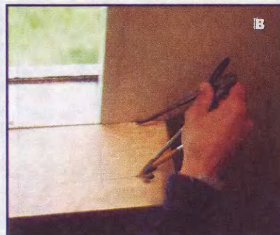
Фото 4. Подгонка подоконника. Для разметки положения ребра между откосом оконного проема и стеной на заготовке подоконника используется обычный угольник (фото 4, а). Для разметки линии сопряжения между откосом и подоконником был применен складной угольник. Эта линия под замеренным углом была проведена через вершину ребра (фото 4, б). В заключение, установив циркуль по глубине подоконной части стены, разметим выступ («на ус») подоконника, примыкающего к стене (фото 4, в)
