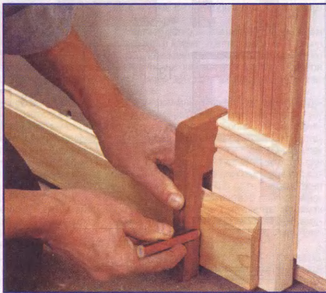
Фото 3. Скоба. Во многих случаях для подгонки деталей можно использовать разметочную скобу. Во время работы ее плотно удерживают у наличника (в данном случае у его цокольного блока) непосредственно на плинтусе.
