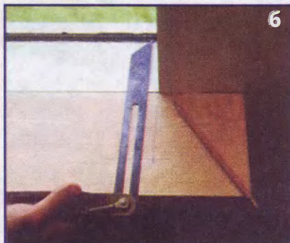
Фото 4. Подгонка подоконника. Для разметки положения ребра между откосом оконного проема и стеной на заготовке подоконника используется обычный угольник (фото 4, а). Для разметки линии сопряжения между откосом и подоконником был применен складной угольник. Эта линия под замеренным углом была проведена через вершину ребра (фото 4, б). В заключение, установив циркуль по глубине подоконной части стены, разметим выступ («на ус») подоконника, примыкающего к стене (фото 4, в)
